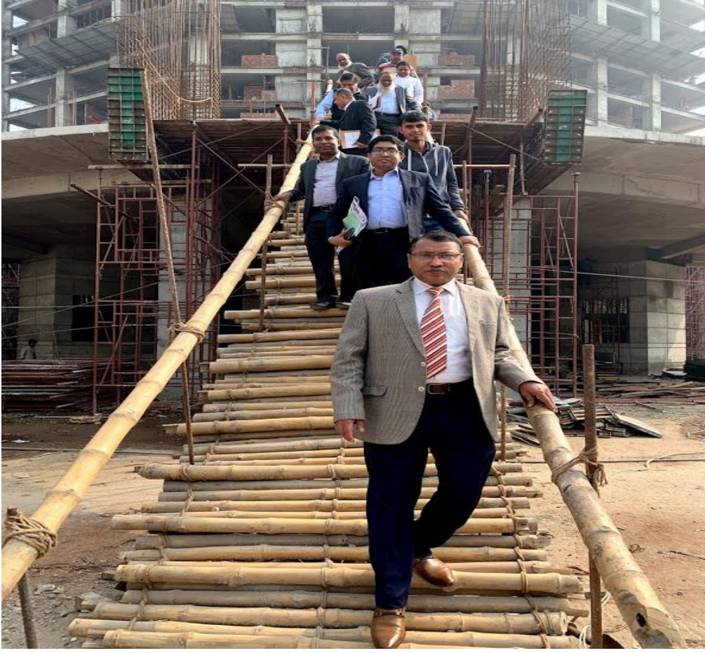
নির্মাণাধীন ভূমি ভবন পরিদর্শন
